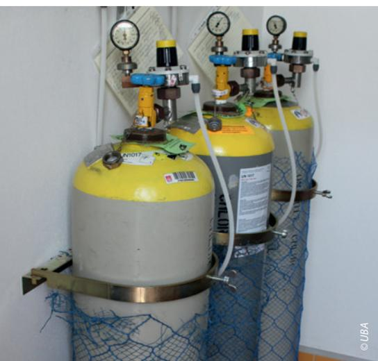
Chlorgasflaschen zur Desinfektion von Schwimmbadwasser.
